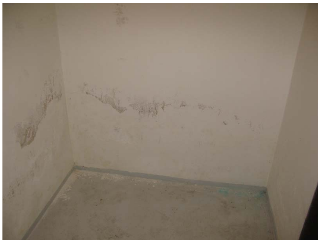
chodba v 1.PP
