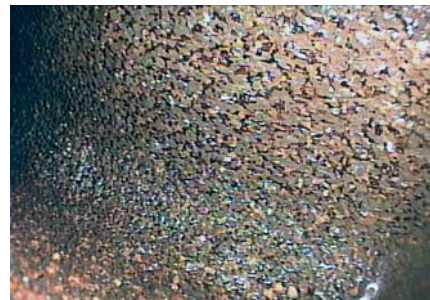
Stěna radiátoru před/po čištění
