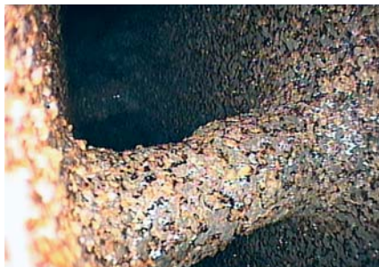
Spoj článků radiátoru před/po čištění
