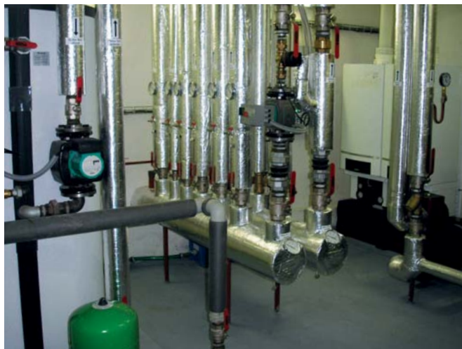
Kotelna plynová po rekonstrukci
