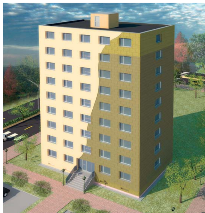
B) Zjednodušené řešení pomocí kombinované izolace Isover TWINNER.
