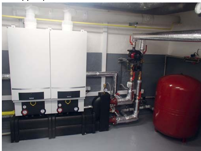
Kotelna plynová po rekonstrukci
