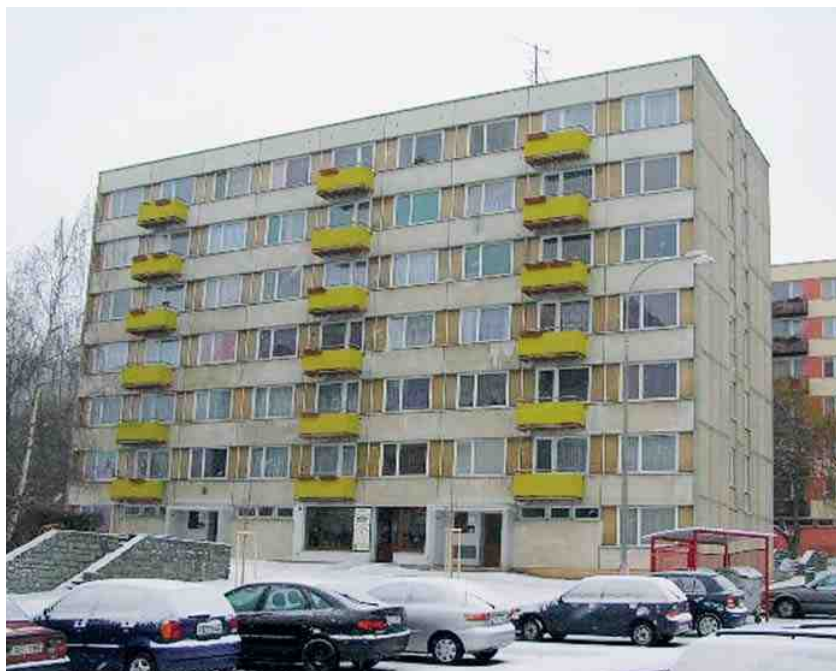
686 a 687 před opravou...
