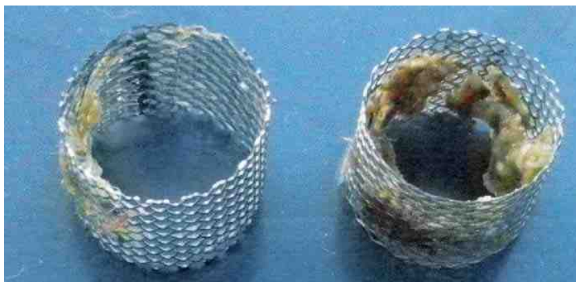
Filtry z ventilů – roháčků – pro připojení umývadlové baterie. Vlevo z PWH, vpravo z PWC (!) po 7 měsících provozu
