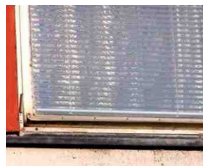
Jedním z nejčastějších důvodů rekonstrukce je zlepšení tepelné izolačních vlastností domů. Zpravidla začíná výměnou starých oken.
