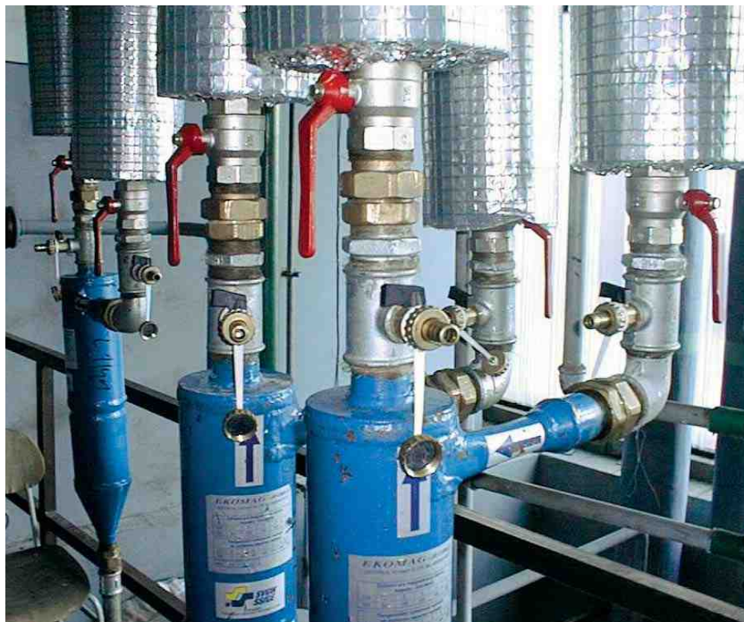
Tangenciální odlučovač nečistot z vody - EKOMAG - zdravotnické zařízení, je instalace na PWC, PWH i PWH-C (běžně stačí na PWH)
