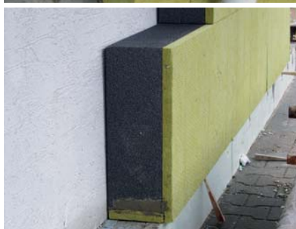
Obr. 13, 14: Příklady řešení detailů zateplení ETICS s izolačním Isover TWINNER.
