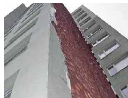
Obr.: Důsledky neřešení ztráty stability zateplovacího systému
