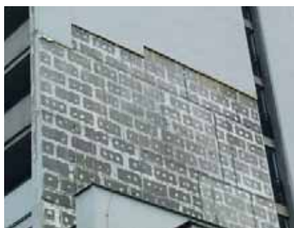
Obr.: Důsledky neřešení ztráty stability zateplovacího systému
