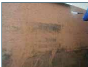
sanace napadené fasády
