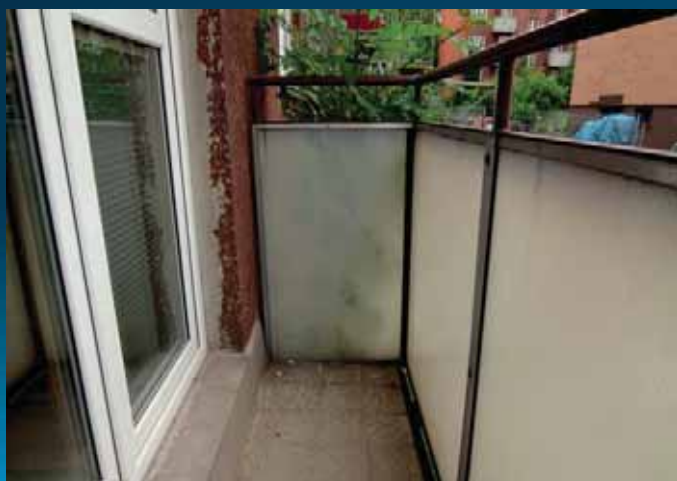
Balkon před realizací
