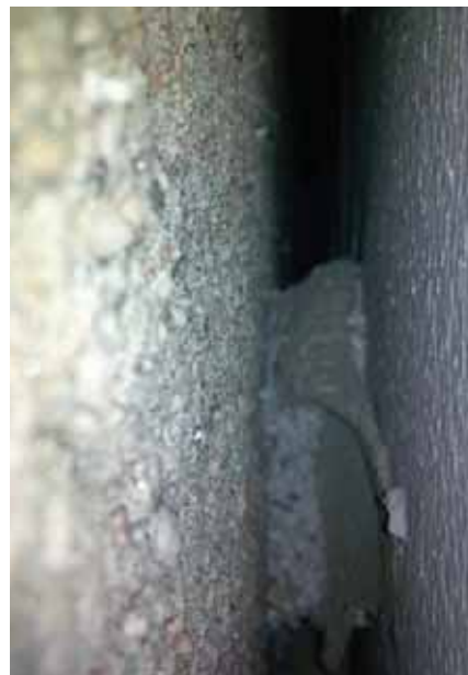
Obr.: snímek z provedené sondy v místě lepení ETICS
